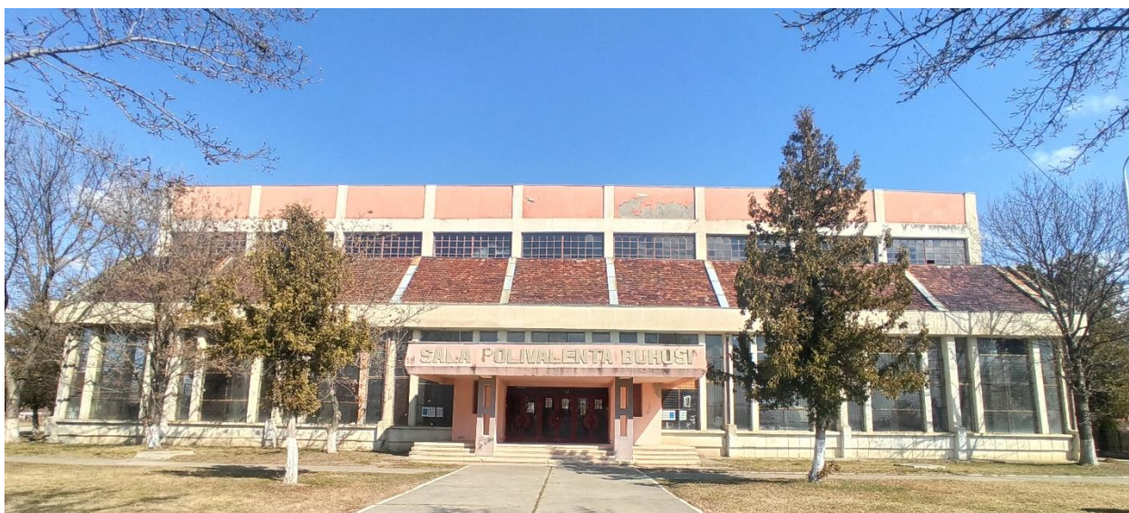
Figura 86 Sala Polivalentă Buhuși (Sursa: fotografie realizată de autori – martie 2022)
