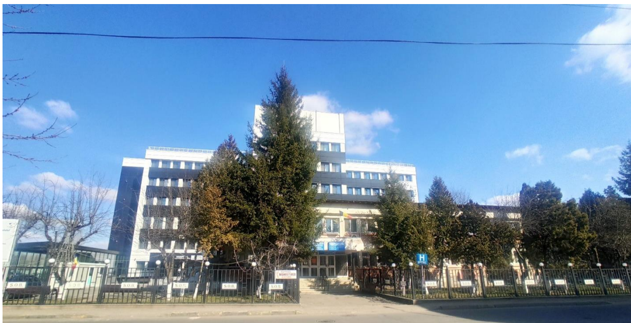
Figura 52 Spitalul „Prof. dr. Eduard Apetrei” Buhuși (Sursa: fotografie realizată de autori – martie 2022)
